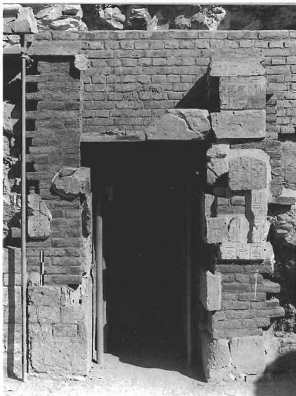
a. Anastilosi della facciata della porta dalla corte al vestibolo
